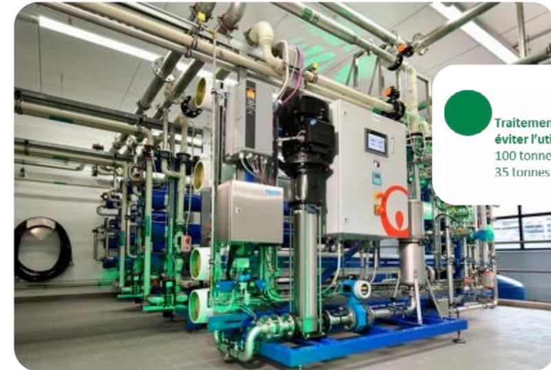
Traitement par osmose inverse pour éviter l'utilisation annuelle de 100 tonnes d'acide chlorhydrique/an 35 tonnes d'hydroxyde de sodium/an
